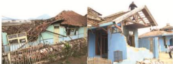
Kerusakan sarana pendidikan dan pemukiman akibat gempa bumi berkekuatan 7,3 SR di 142 km Barat daya Tasikmalaya.
