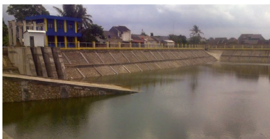
Gambar 6. Polder Pengasinan. Sumber Foto: Dinas Bina marga.
