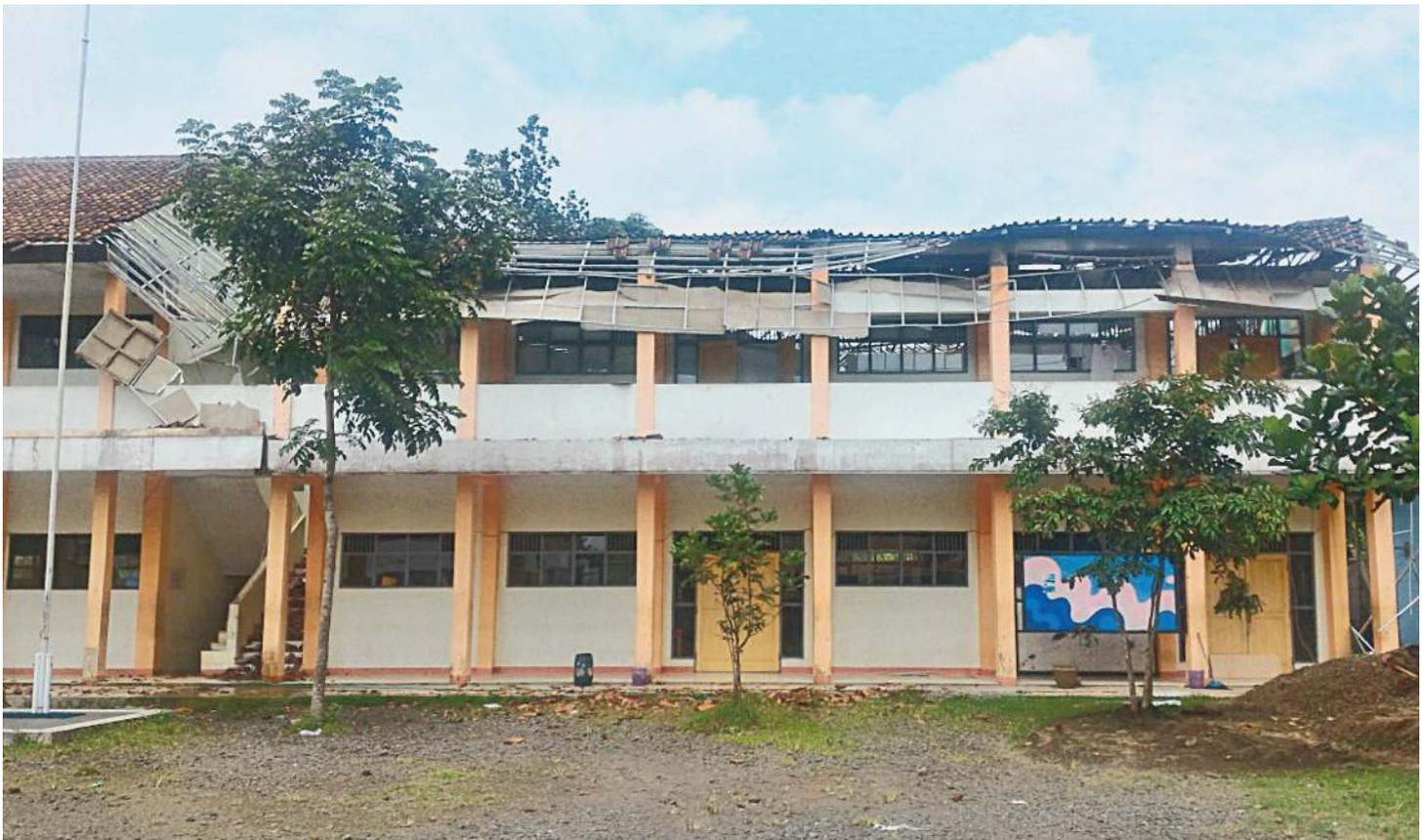
Rangka dan Penutup Atap Mengalami Deformasi SMKN 3 Tasikmalaya.
